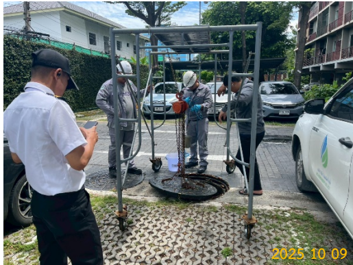
ภาพที่ 2-15 เจ้าหน้าที่ตรวจสอบบ่อพักระบายน้ำ
