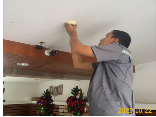
ภาพที่ 2-27 เจ้าหน้าที่ตรวจสอบระบบป้องกันอัคคีภัย
