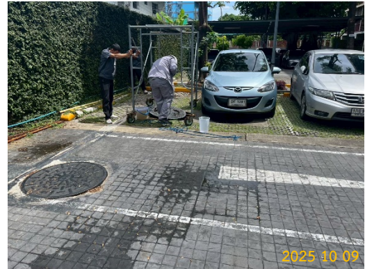
ภาพที่ 2-15 เจ้าหน้าที่ตรวจสอบบ่อพักระบายน้ำ
